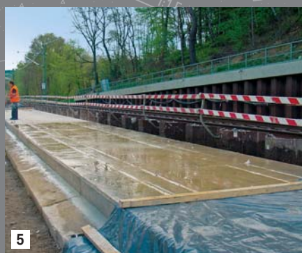
Fertigstellung der Formschalungselemente sowie Einbau und Verdichtung des Betons C 30/37 LP mittels Schlauchpumpe.
