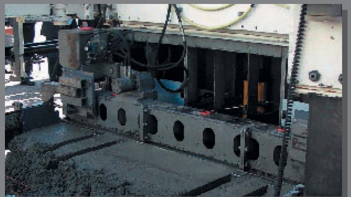
Fertigung Betontragplatte mit Längsnuten
