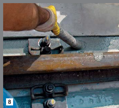
Endkontrolle der Gleislage und Verguss der Längskanäle mit Präzisionsvergussmörtel.
