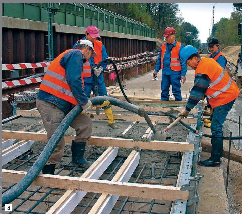
Fertigstellung der Formschalungselemente sowie Einbau und Verdichtung des Betons C 30/37 LP mittels Schlauchpumpe.
