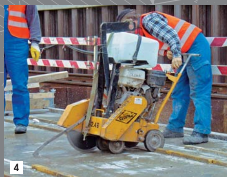
Herstellung der Scheinfugen mittels Kerbschnitt mit einer Mindesttiefe von 0,12 m und Nachbehandlung des Betons gemäß DIN 1045 mittels Befuchtung und luftdichter Abdeckung.
